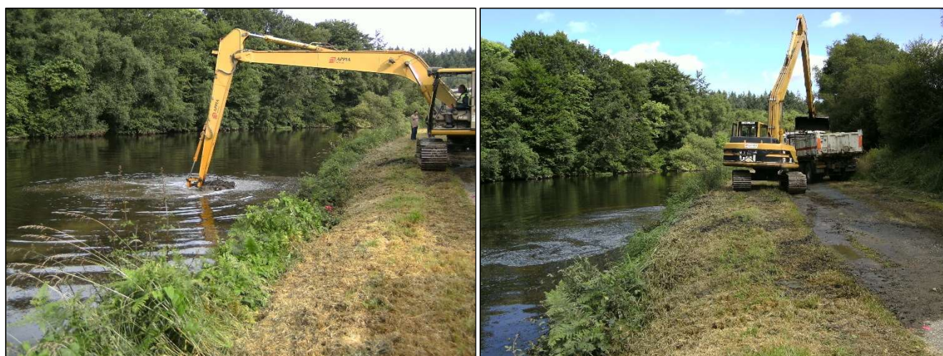
Figure 4 : Exemple de dragage mécanique à partir d'une berge
