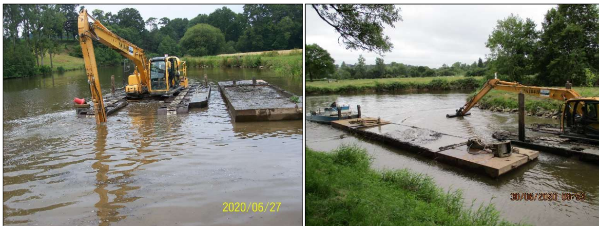
Figure 3 : Exemple d'atelier Dipper (ponton-pelle) et de pelle amphibie avec chargement de barge (photo IDRA Environnement et Région Bretagne)
